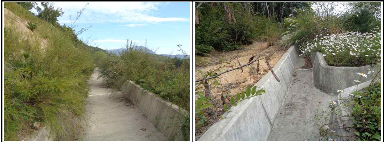
【그림 8.3.3】 배수시설 전경
